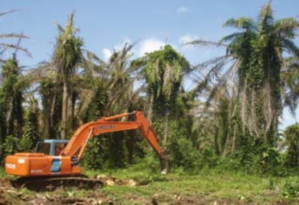
▣ Lote de renovación picado con excavadora.
